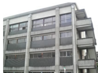
壁面(工損調査)
