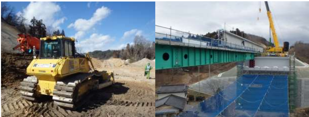
施工時の様子
